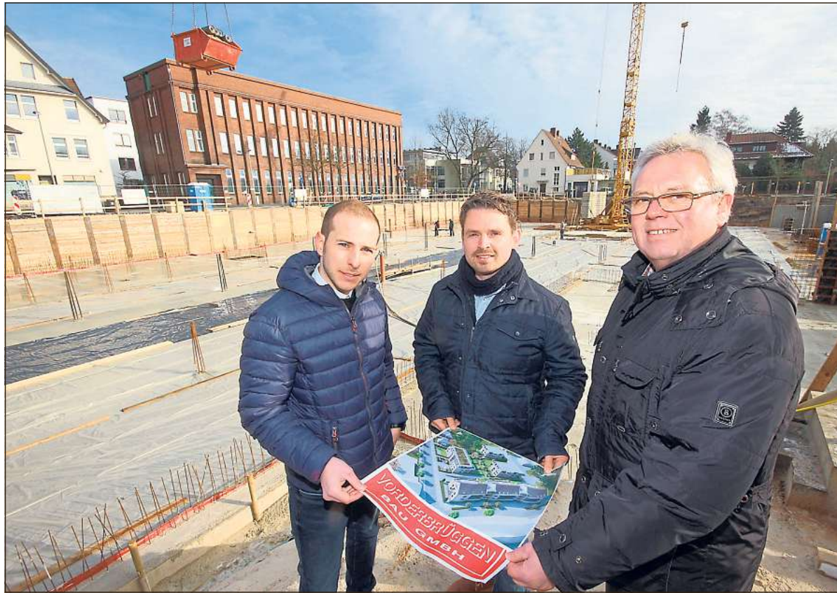
Treiben den Neubau voran: (v. l.) Bauleiter Benedikt Schneider, Prokurist Christian Vorderbrüggen und Geschäftsführer Dieter Vorderbrüggen auf der Baustelle an der Carl-Bertelsmann-Straße. Bild: Dinkels
