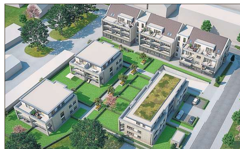
Aus der Vogelperspektive: Rechts ist die Molkerei- oben die Carl-Bertelsmann-Straße zu sehen. In den drei unteren Häusern entstehen Eigentumswohnungen. Für die architektonische Planung zeichnet das Verler Büro Wischke Send und Partner verantwortlich.
